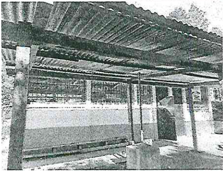
Foto1: Sustrución de cubierta de techo con lámina galvanizada, Tipo de lamina: troquelada Calibre: 26, incluye: fijaciones y sellado en traslapes.
